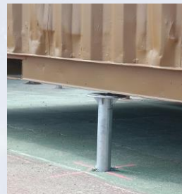
Snack communal réalisé sur vis de fondations pour les terrassements....
