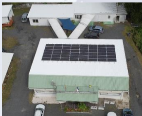
Photovoltaïques bâtiments communaux
