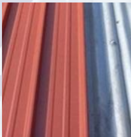
Pose de sur-toitures isolantes
